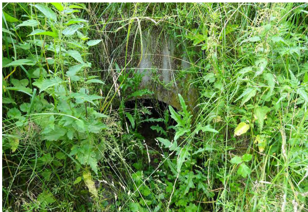
Fot. 9. Miejsce budowy proggu piętrzącego (Nowe Sady) / Photo 9. Construction site of the water dam (Nowe Sady)
