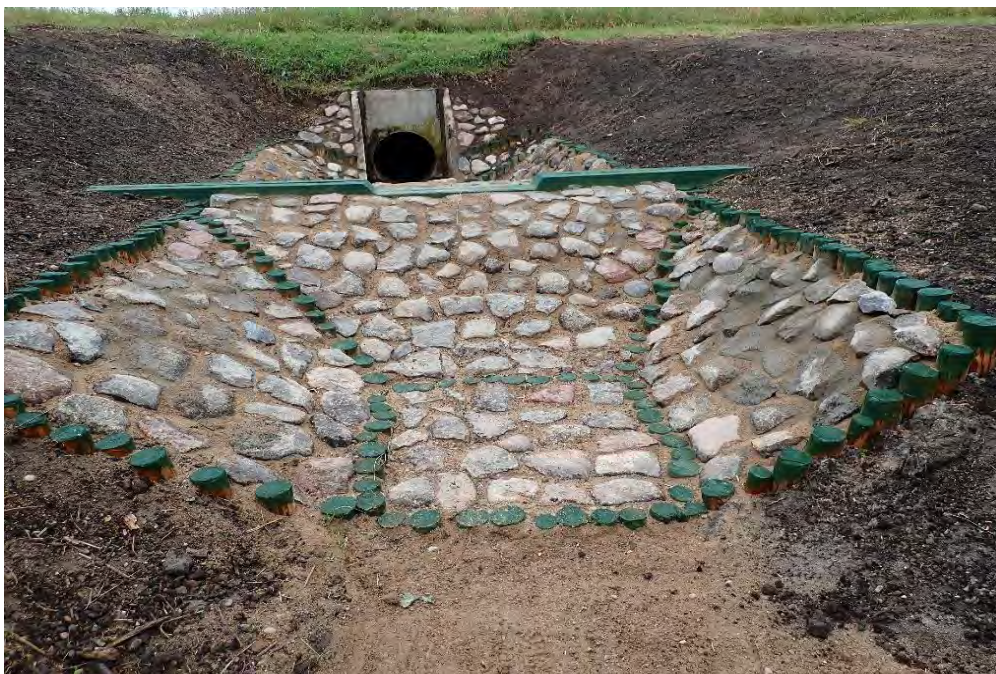
Fot. 10. Próg piętrzący w rowie odwadniającajym w Nowych Sadach / Photo 10. The dam in a drainage ditch in Nowe Sady
